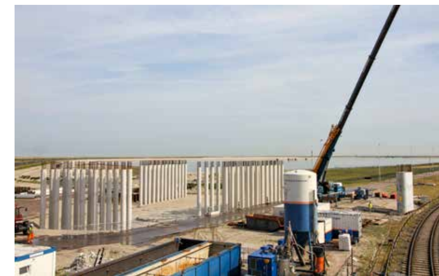
Werkzaamheden CER in volle gang.
